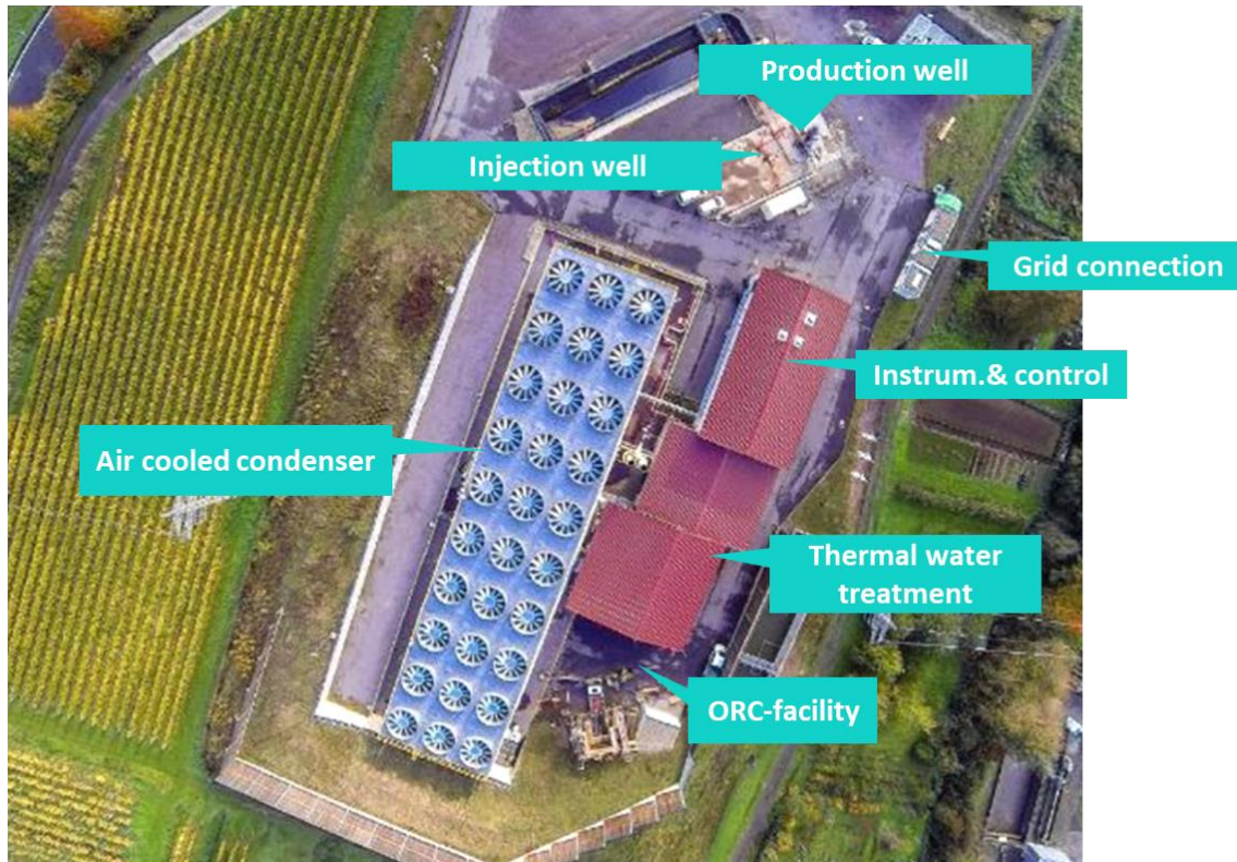
Figure 11 : Vue aérienne de la centrale géothermique d'Insheim et description des installations.
