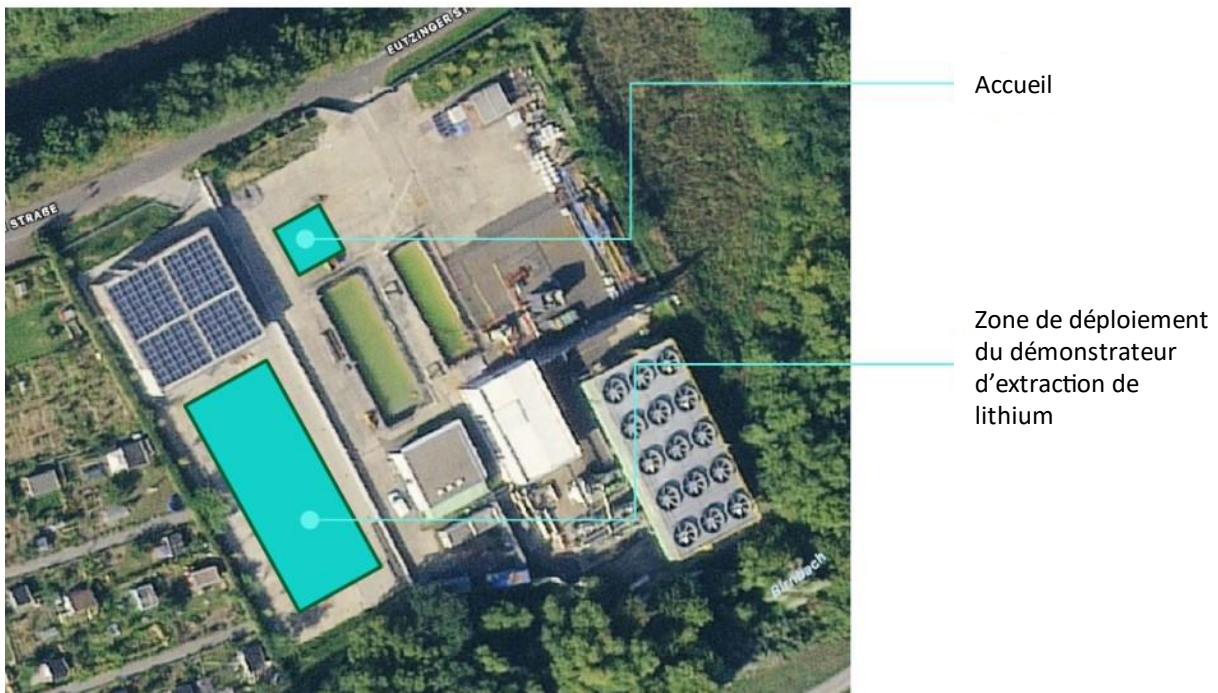
Figure 18 : Image aérienne de la centrale géothermique de Landau et positionnement en surface des équipements dédiés au démonstrateur d'extraction de lithium.
