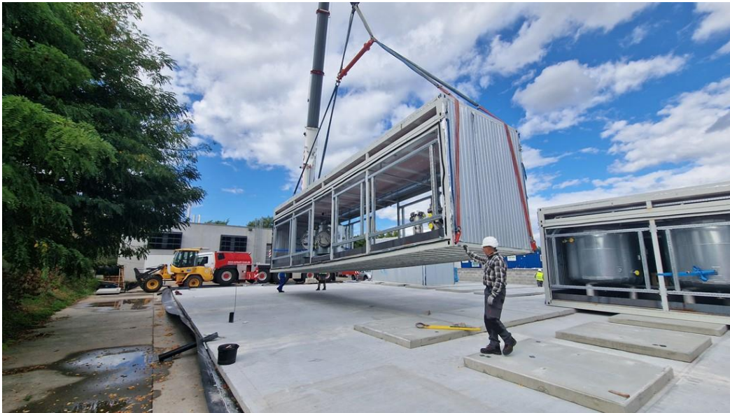
Figure 20 : Mise en place de la dalle béton et des conteneurs qui hébergeront le démonstrateur d'extraction de lithium sur le site de Landau.
