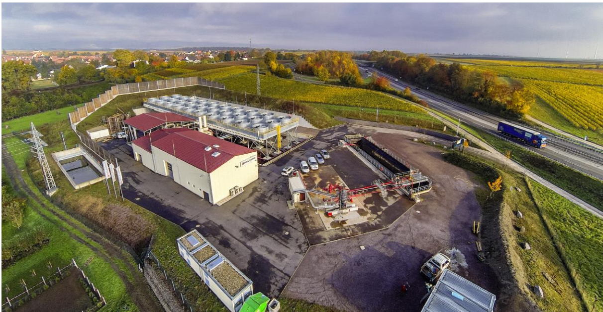
Figure 10 : Vue aérienne de la centrale géothermique d'Insheim représentant environ 1 ha de surface.
