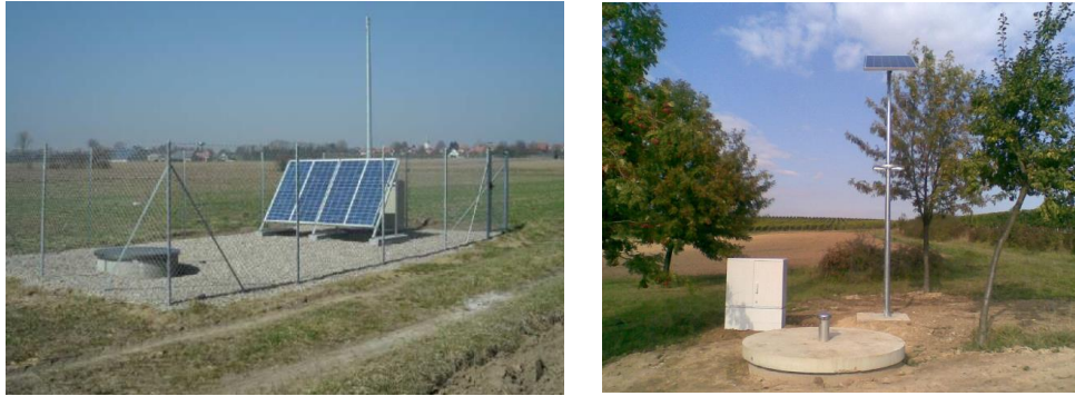
Figure 78 : Exemple de stations temps-réel. A gauche pour le monitoring de la centrale de Rittershoffen (Source : (Ravier et al. 2016) et à droite pour le monitoring de la centrale d'Insheim (Source : (Küperkoch et al. 2016)).
