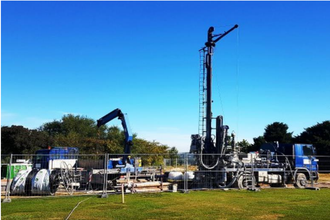
Illustration n° 15 : Photo des travaux de forage (Source : Weishaupt).
