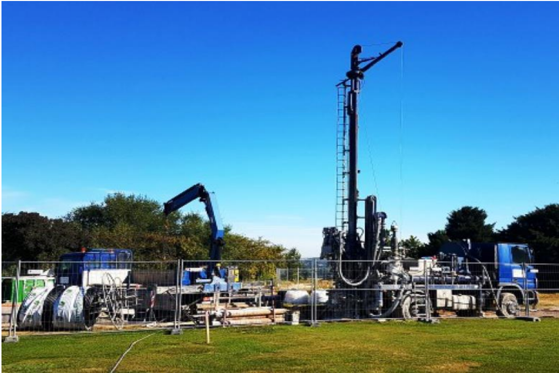
Illustration n° 15 : Photo des travaux de forage (Source : Weishaupt).
