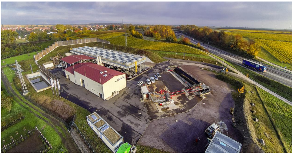
Figure 4 : Vue aérienne de la centrale géothermique d'Insheim représentant environ 1 ha de surface.
