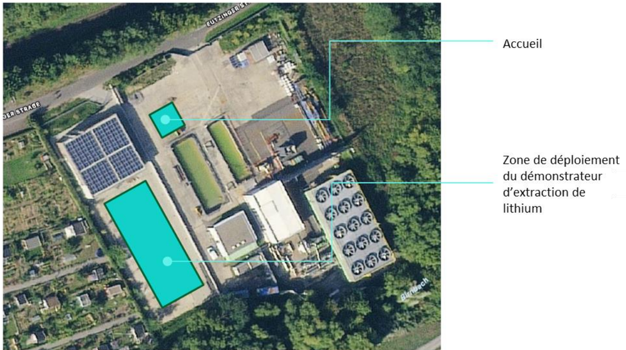
Figure 14 : Image aérienne de la centrale géothermique de Landau et positionnement en surface des équipements dédiés au démonstrateur d'extraction de lithium.
