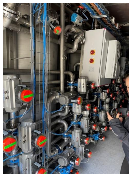
Figure 17 : Réception des cuves d'extraction (à gauche) et montage du système d'automatisation du processus de concentration de la saumure en lithium géothermal (à droite).
