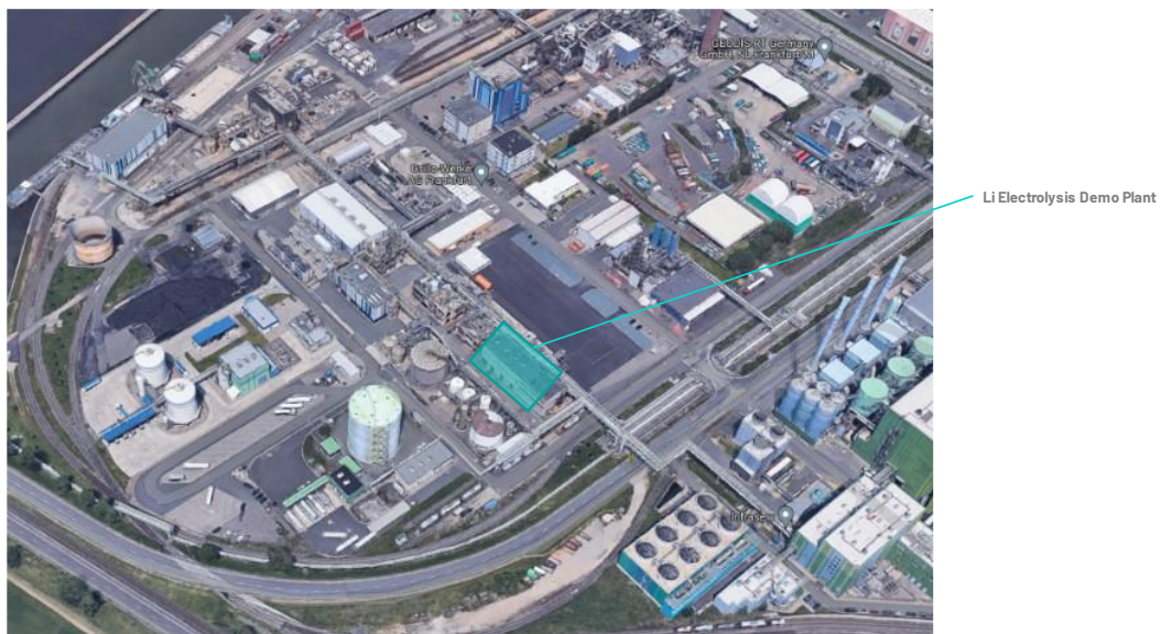
Figure 19 : Site d'implantation de la centrale de conversion localisé dans le parc chimique d'Höchst de Frankfurt (un des plus grands d'Allemagne avec 460 hectares) proche des infrastructures de notre partenaire Nobian.
